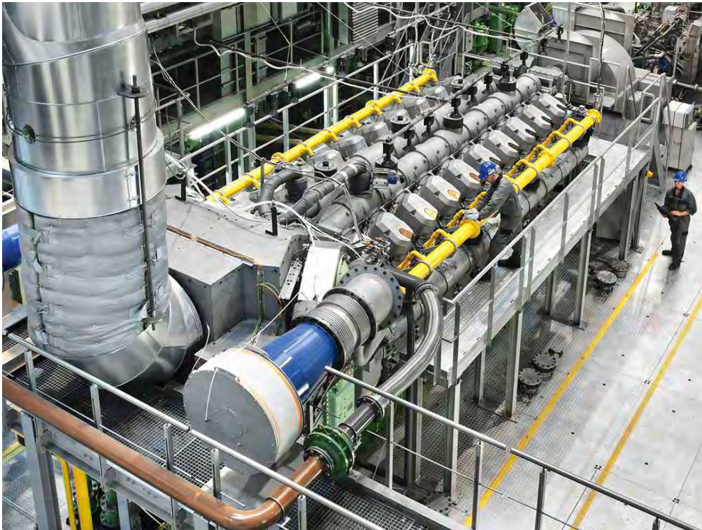
Fig. 18: De "H2-ready" gasmotor van MAN (bron: https://www.man-es.com/de/unternehmen/pressemitteilungen/presse-details/2021/11/04/h2-ready-man-gasmotoren-maken-waterstof-gebruik-in-krachtcentrales-mogelijk )
