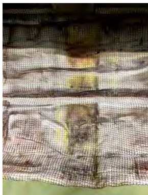
Afb.87-95: De-installatie van ontsmette thermische isolatie die calcium bevat
