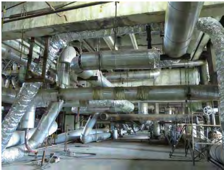
Fig. 7: Isolatie van krachtcentrale
