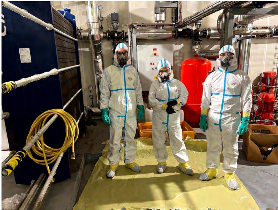
Fig.87: Volledige beschermende kleding voor aanvang van de de-installatie- en decontaminatiewerkzaamheden
