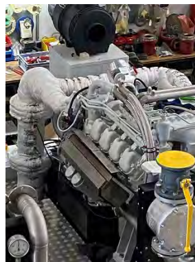
Afb. 70/Fig.71 Rookgaspijp WKK geïsoleerd calciumvrij
