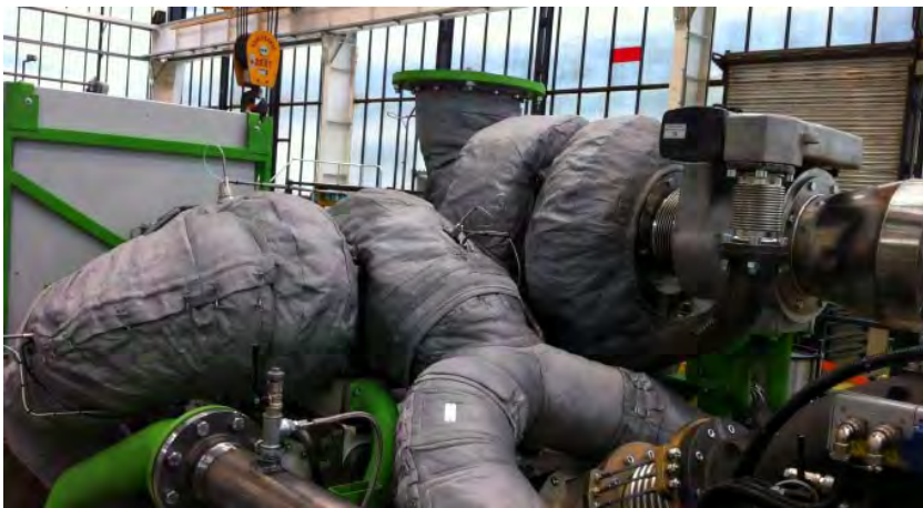
Fig12: Motorisolatie met isolatiematten
