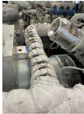
Fig. 66/Fig.67 WKK- uitlaatpijp geïsoleerd calciumvrij
