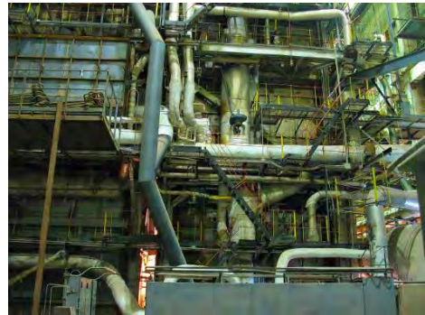
Fig. 8: Isolatie van krachtcentrale
