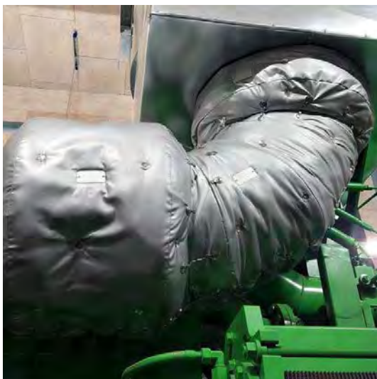
Fig13: Isolerend uitlaatgebied matrassen
