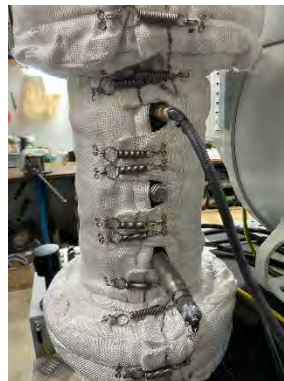
Afb. 68/Fig.69 Afvoerleiding WKK- eenheid geïsoleerd calciumvrij
