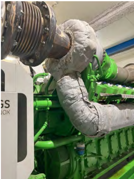
Abb.1: wärmegeämmter Gasmotor
