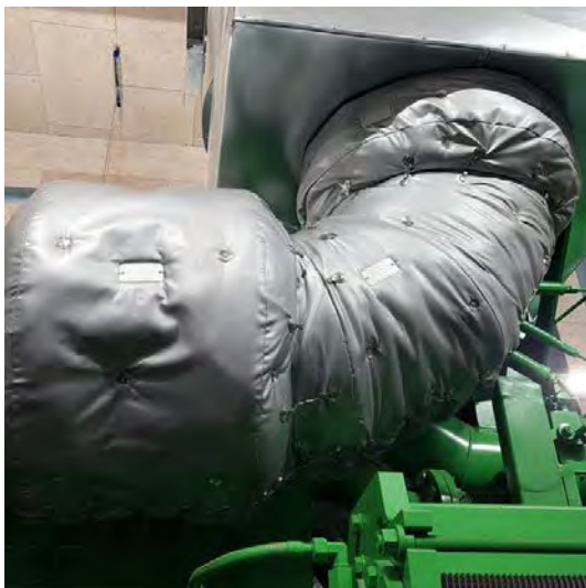
Abb13: Isoliermatratzen Abgasbereich
