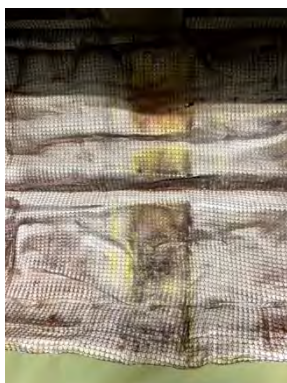
Abb.87-95: Deinstallation dekontaminierter, calciumhaltiger Wärmedämmungen
