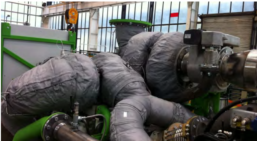
Abb12: Motorenisolierung mit Isoliermatten
