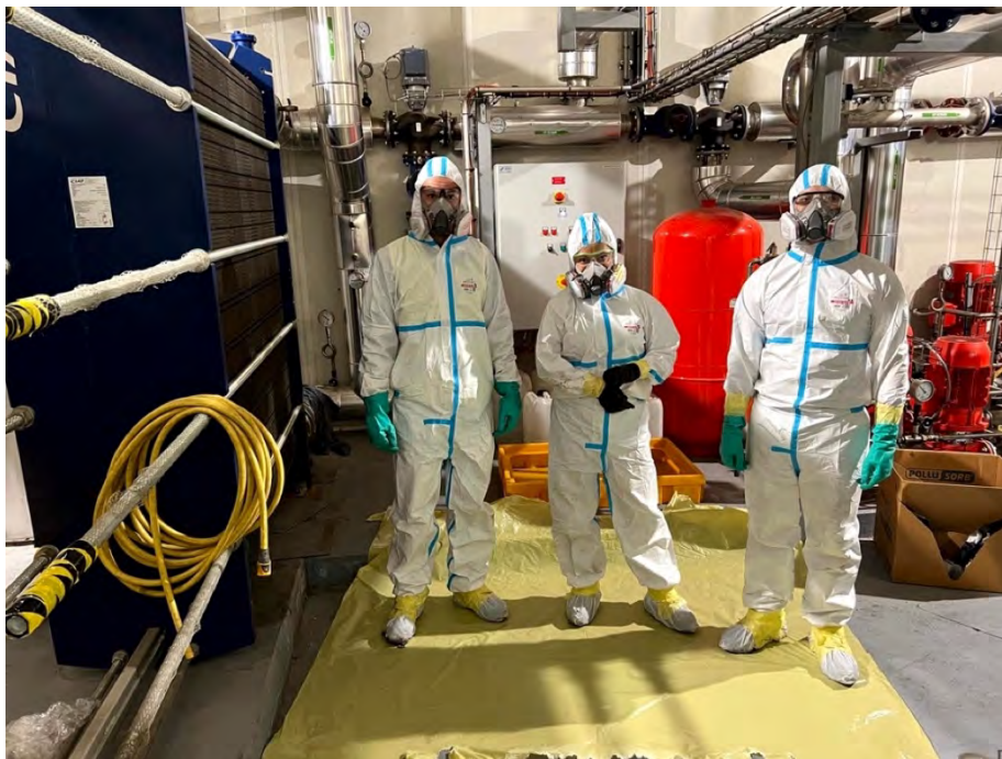
Abb.87: Volle Arbeitsschutzkleidung vor Aufnahme der Deinstallations- und Dekontaminationsarbeiten
