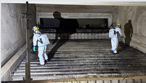
Benetzen vor Arbeitsbeginn auf dem Rost. Vollmaske, Einweg-Schutzanzug mit Kapuze, Handschuhe.
