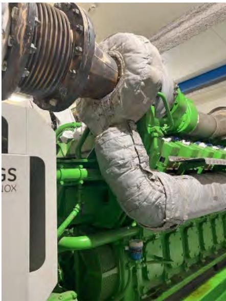
Abb.1: wärmegeämmter Gasmotor
