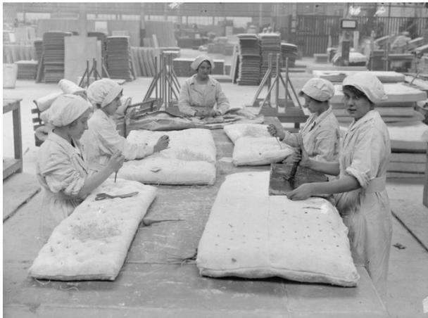
Abb2: Fertigung von Asbestmatratzen um 1920
