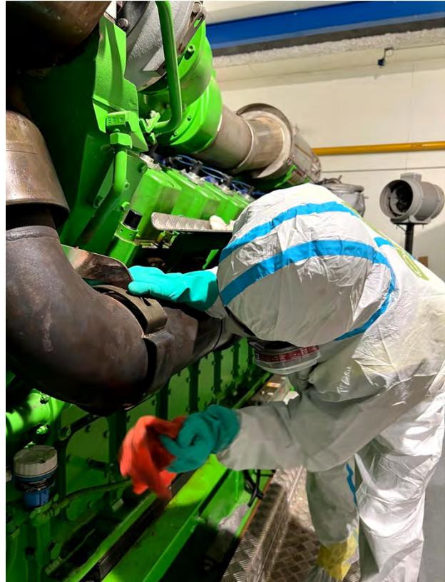
Abb.96-99: Dekontamination von Anlagenteilen
