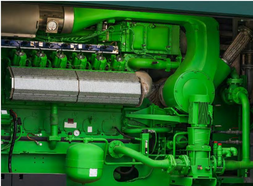
Abb.45: Gasmotor im engen Containereinbau (Blockheizkraftwerk)
