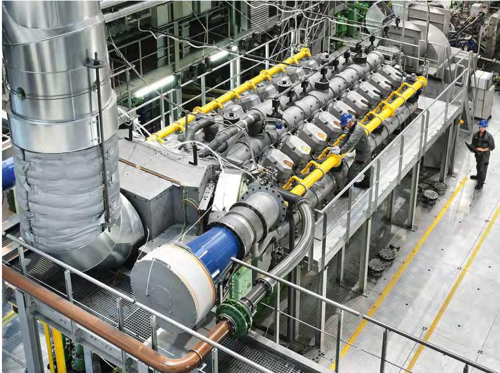
Abb. 18: „H2-ready“-Gasmotor der MAN (Quelle: <https://www.man-es.com/de/unternehmen/pressemitteilungen/press-details/2021/11/04/h2-ready-man-gasmotoren-ermoenlichen-wasserstoffeinsatz-in-kraftwerken>)
