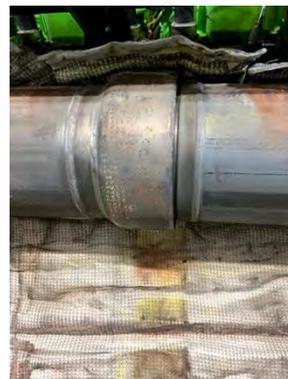
Abb.88-95: Deinstallation dekontaminierter, calciumhaltiger Wärmedämmungen
