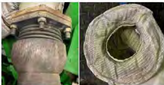
Cr-6 Ablagerungen auf einem Kompensator (gelbliches Pulver)
